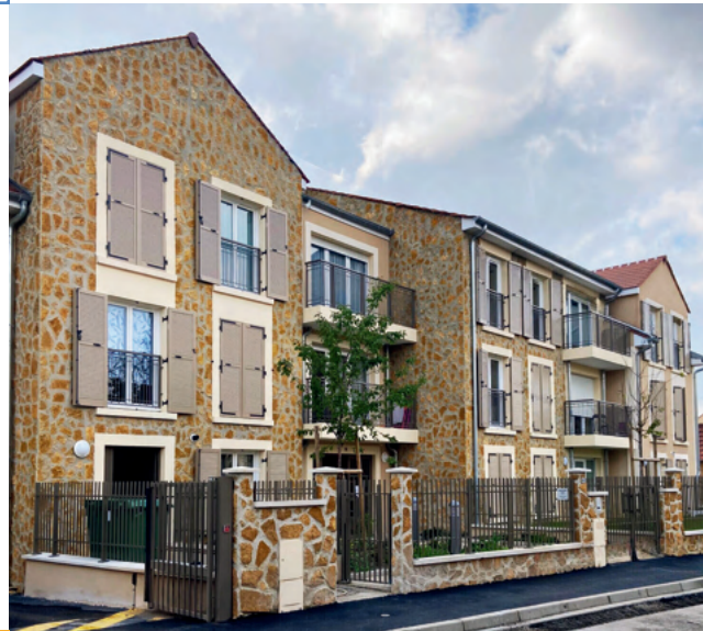
Green Villa Rambouillet 78
